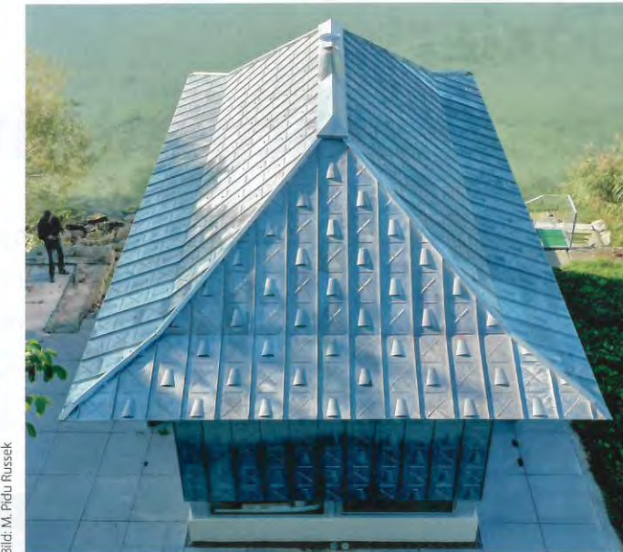
Besonders knifflig war die saubere und einheitliche Fortführung des Reliefmusters, vor allem an den Graten
