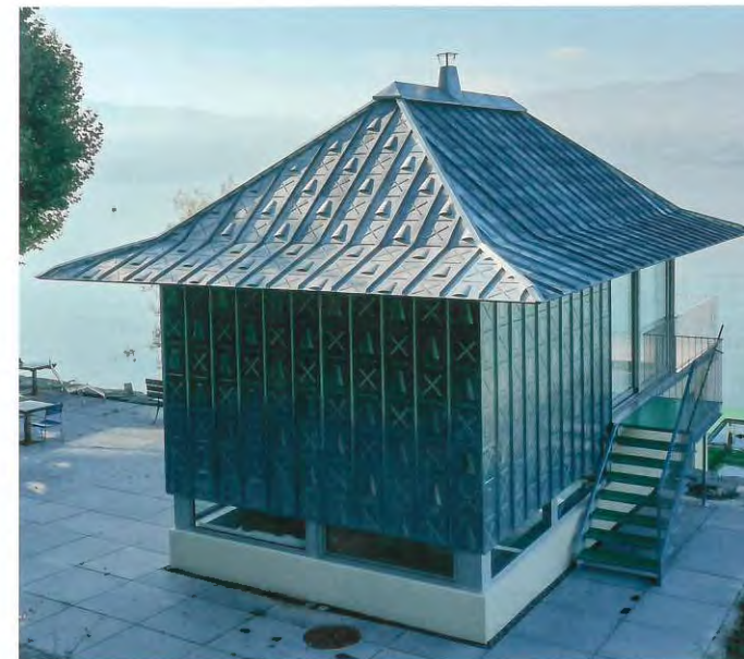
Insgesamt wurden rund 200 m 2 Fläche in Doppelfalztechnik auf dem Dach und in Winkelfalztechnik an der Fassade eingedeckt
